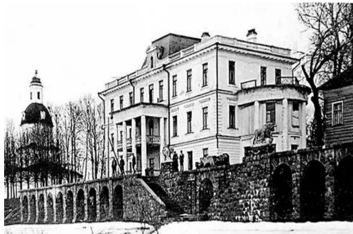
Усадьба Мусиных-Пушкиных в Иловне. Архитектор А.И. Таманян
