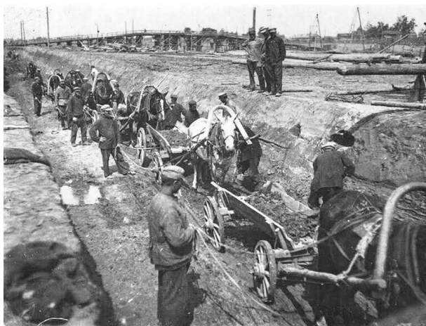
Заклученные Волголага на строительстве Рыбинской ГЭС
